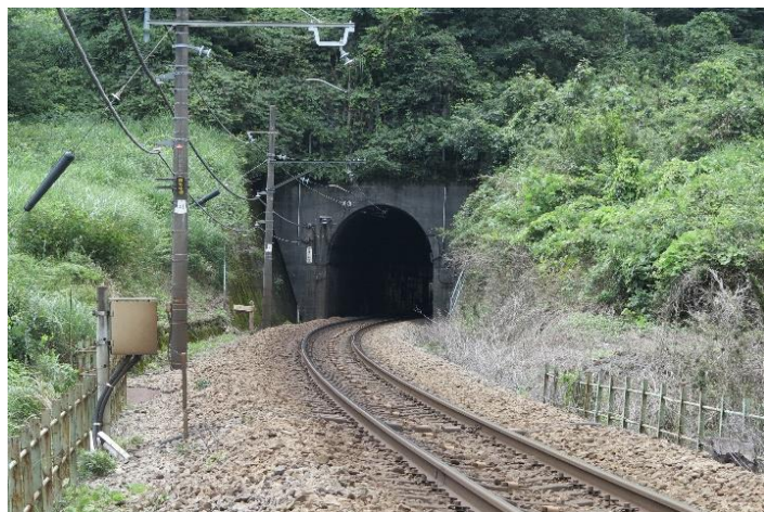
湯の花トンネル（新井踏切から）
